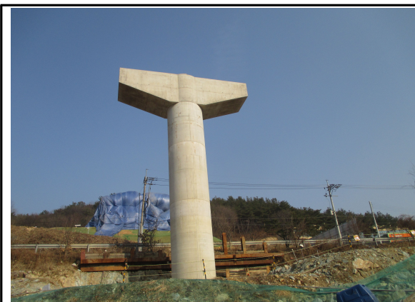
P4 교각 시공 현황
