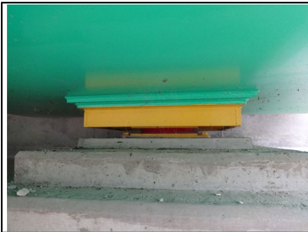
교량받침 A1-SH2 전경
