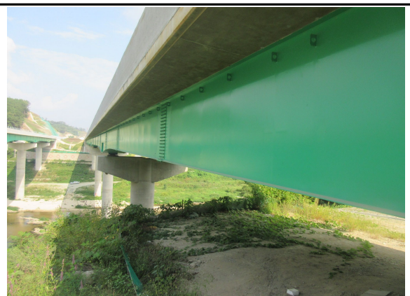
BOX 외부 시공 상태 점검
