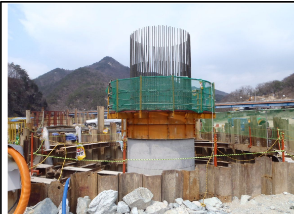
P2 교각 시공 현황
