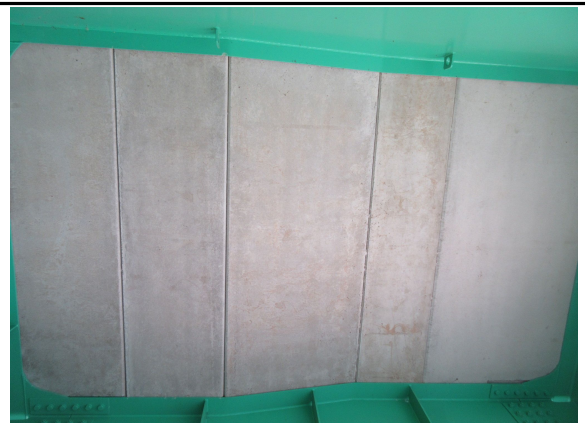
바닥판 하면(LB-DECK) 시공 상태 점검
