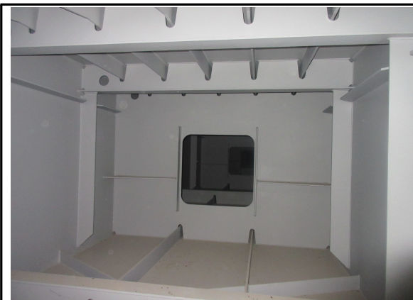
BOX 내부 시공 상태 점검
