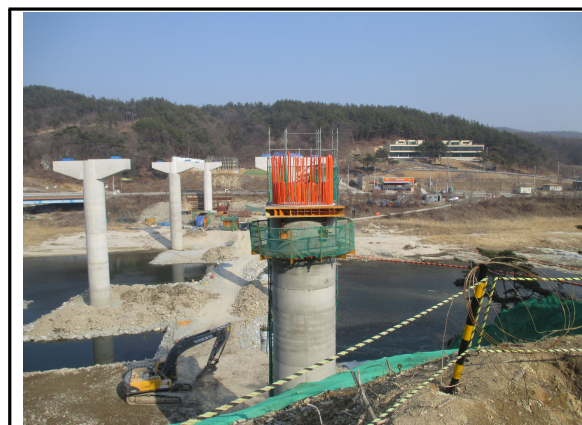
P1 교각 시공 현황
