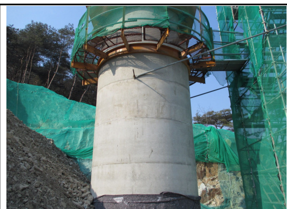
P1 교각 시공 상태
