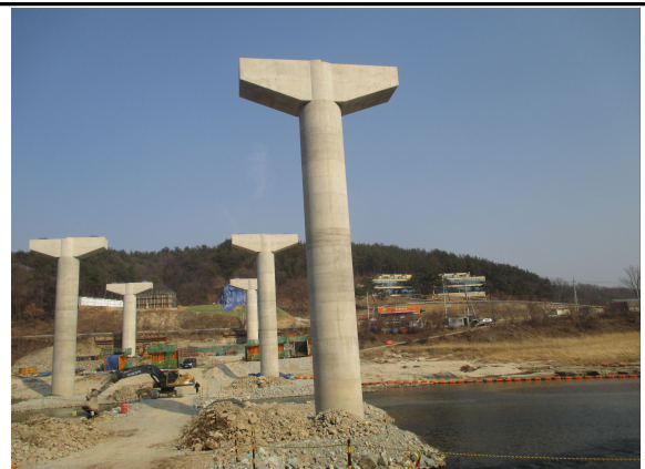
P2 교각 시공 상태
