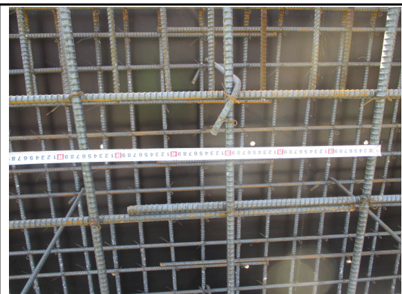
A1 교대 흉벽 배근 간격 측정
