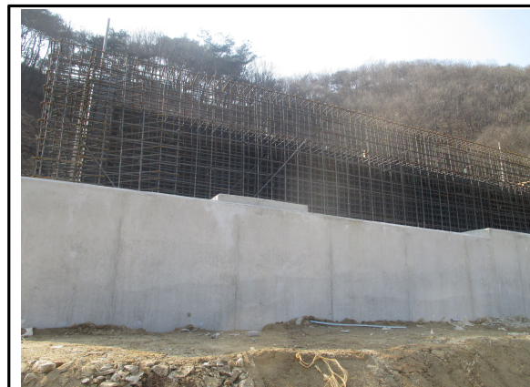
A1 교대 시공 현황
