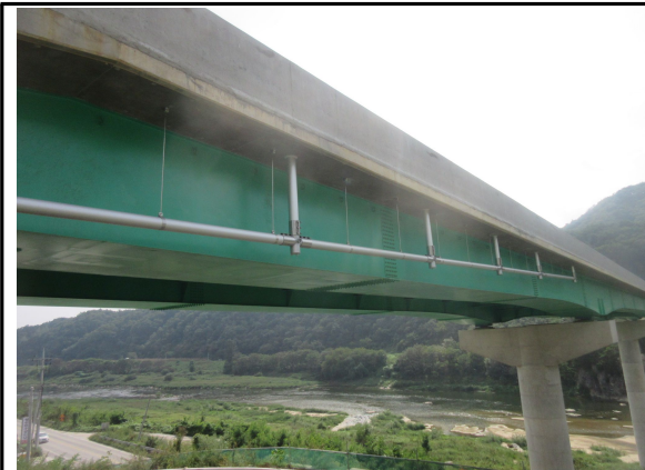
배수관 시공 상태 점검(원주방향)
