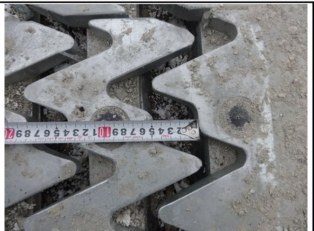
신축이음 A2 유간 측정
