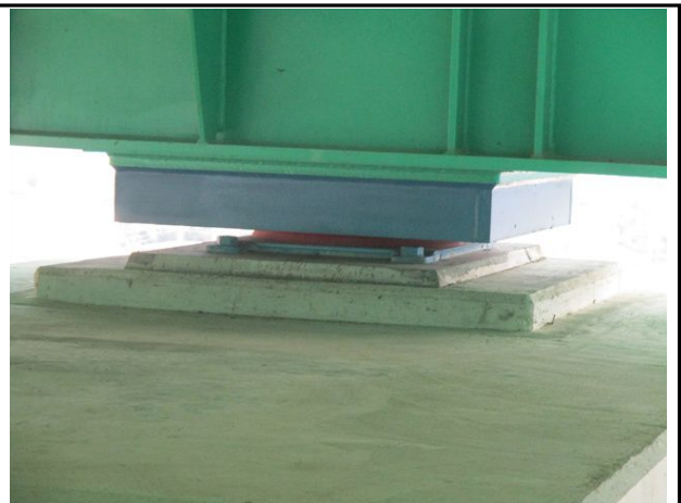
교량받침 P1-SH2 전경
