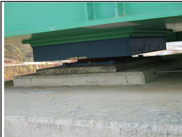
교량받침 P3-SH1 전경
