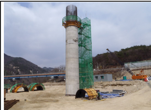
P3 교각 시공 현황
