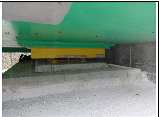
교량받침 A1-SH2 전경
