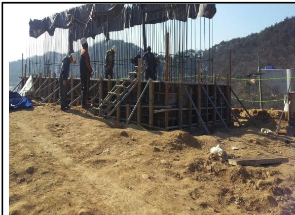
A2 기초 전경
