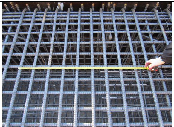
A2 기초 철근 배근 상태
