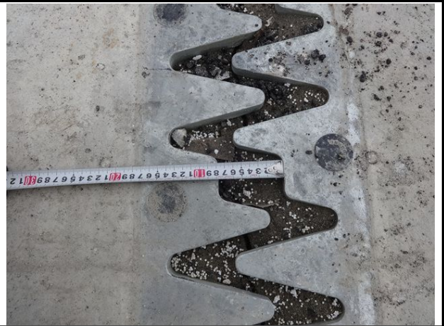
신축이음 A1 유간 측정
